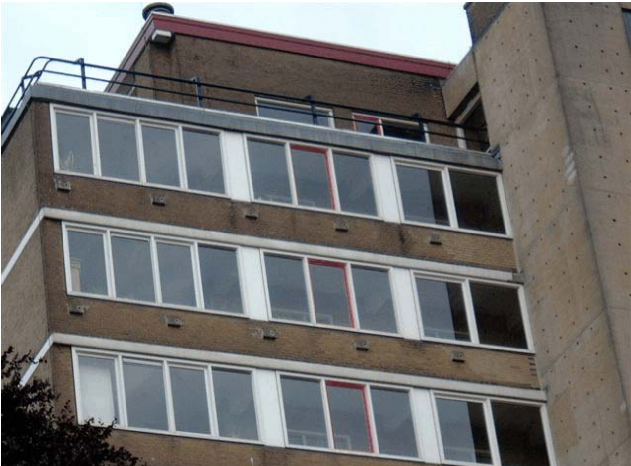
Foto 1. Situatie aanzicht neststenen ATLANTA noordgevel tiende en elfde verdieping.
