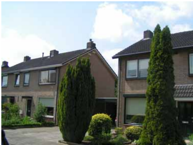
Foto 1. Situatie overzicht Troelstrastraat 11 met de twee nestkasten in de nok.
