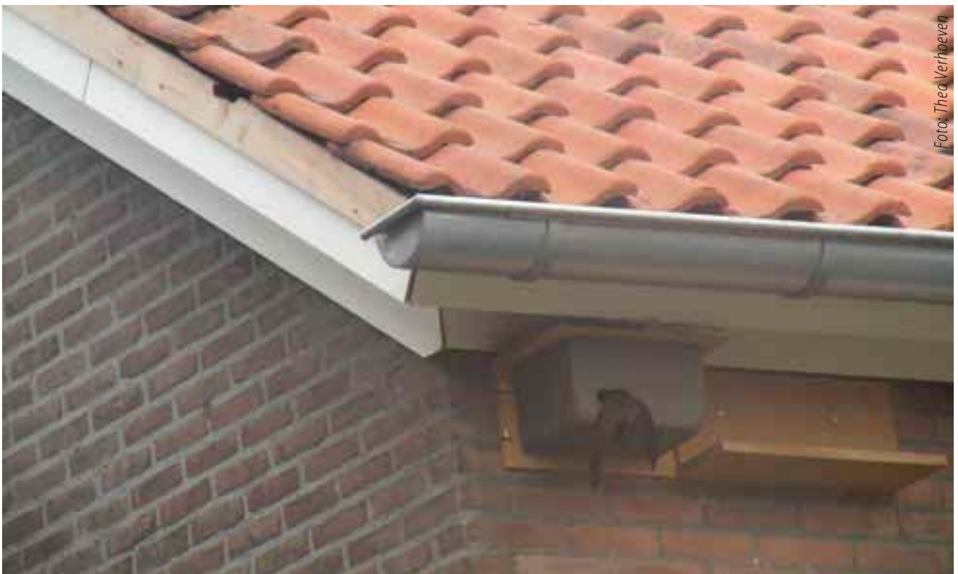
Foto 4. Gierzwaluw neemt nieuwe nestkast in gebruik. Ook zichtbaar is de uitsparing van de betimmering!
